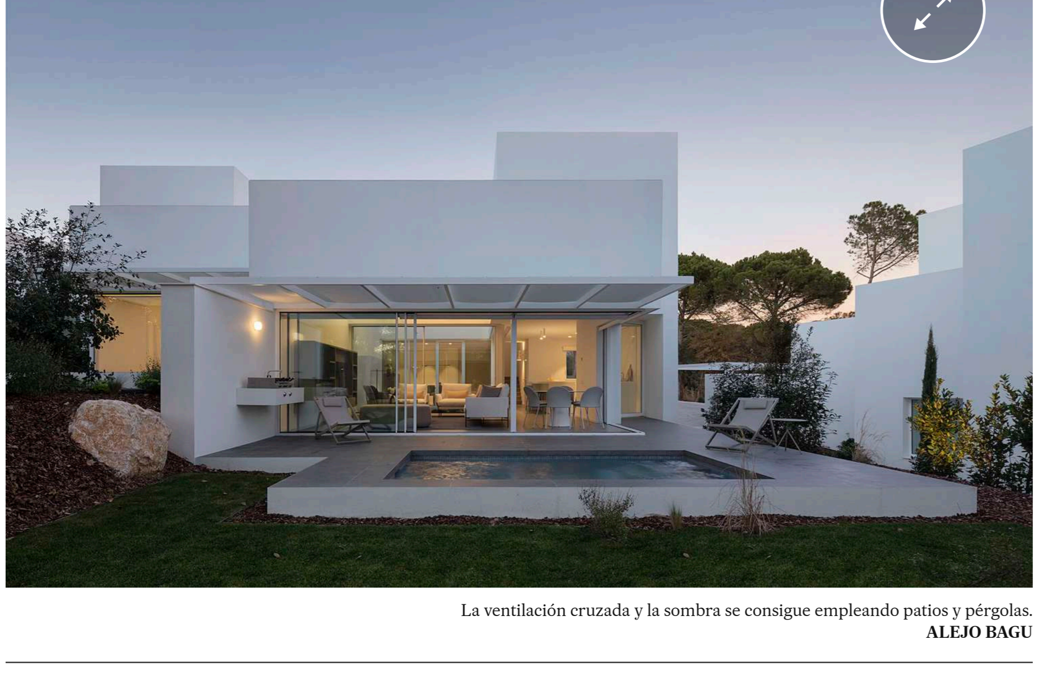
La ventilación cruzada y la sombra se consigue empleando patios y pérgolas. ALEJO BAGUE
