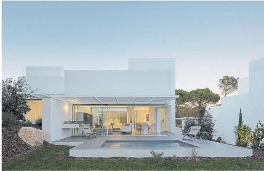
CONTRAFRENTE. El juego volumétrico se repite en la casa, la piscina y los muros.
